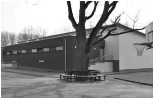
Abb. 4: Ein Schmuckstück: die neue Turnhalle der Grundschule
