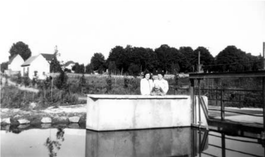
Abb. 5: Der Sandfang des Krufter Bachs im Sonnenland, der regelmäßig ausgebaggert werden muss, ist Thema im Gemeinderat.
